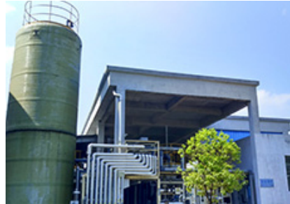
廃水処理施設
