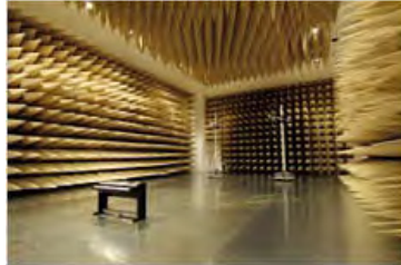
電磁波測定に使用する電波暗室
