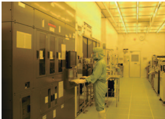
クリーンルーム
