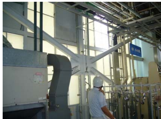
豊岡工場の耐震補強（屋内）
