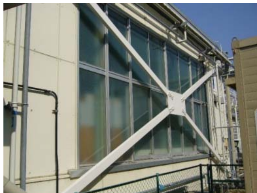
豊岡工場の耐震補強（屋外）
