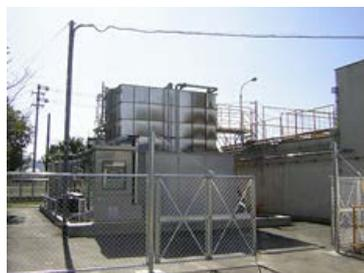
※3 活性汚泥の固液分離に膜(主にMF膜)を用いる方法で、沈殿槽が不要、処理水に大腸菌やSS(浮遊粒子状物質)が含まれない、MLSS濃度(Mixed Liquor Suspended Solids)が高いため短時間で処理が可能、などのメリットがあります。
