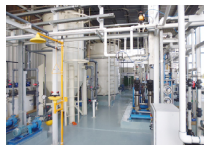
工程廃水を100%再利用
