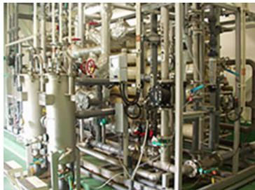
逆浸透膜（RO膜）装置（豊岡工場）
