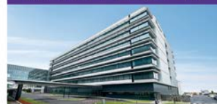
2018年6月 イノベーションセンター稼働
