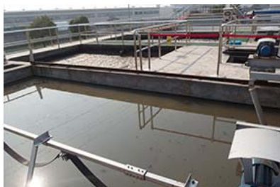
廃水を冷却水などに再利用（杭州ヤマハ）
