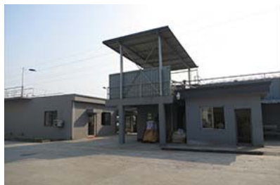
廃水処理施設（杭州ヤマハ）
