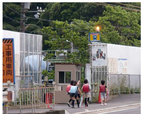
開発製品を設置した工事現場
